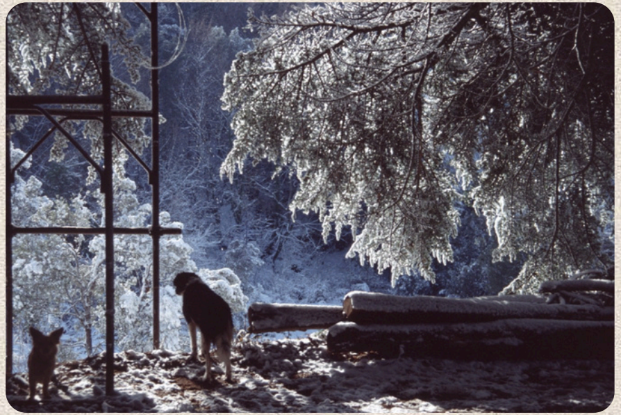
Der Wiederaufbau der Romita, 1993
